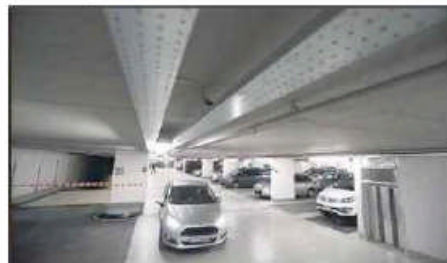
Encore en travaux, un seul étage a été ouvert
