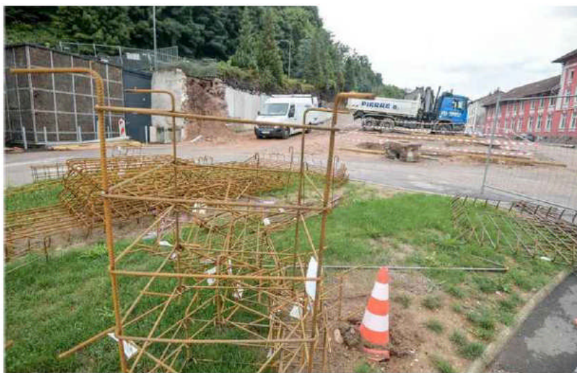
Pour l'heure, sur le chantier du parking Saint-Michel, il s'agit de préparer le terrain à recevoir le futur édifice en ouvrage. Photo Jérôme HUMBRECHT.
