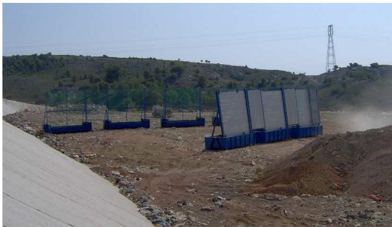
Bennes pare-vent et anti-envol sur casier en exploitation
