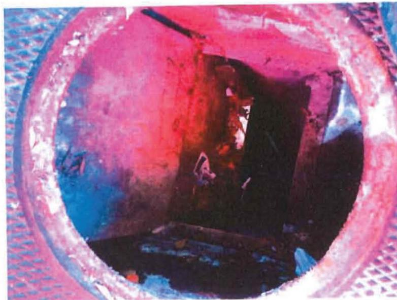
Cette situation est la conséquence de la fermeture trop « violente » du dispositif qui décale les axes du clapet ce qui entraîne, lors du déclenchement suivant, un blocage en position ouverte.
