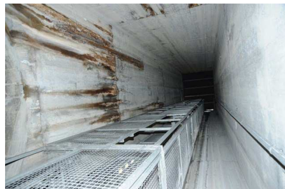
Figure 5 : Vue du puits
