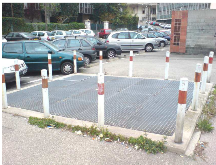
Figure 7 : Vue extérieure de la grille en surface
