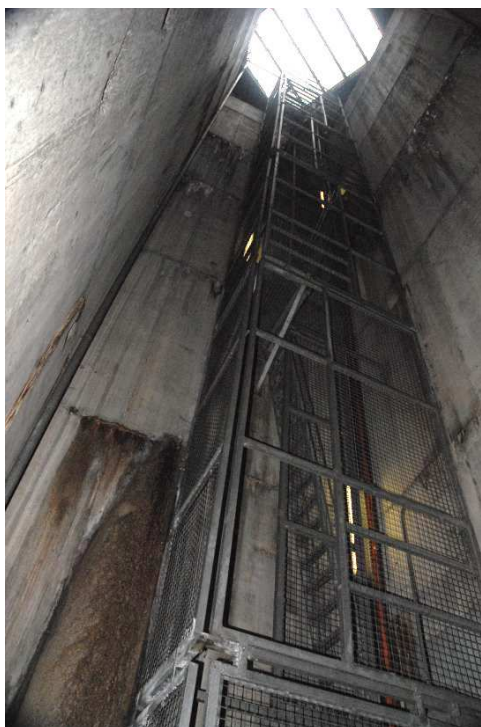
Figure 6 : Vue du puits
