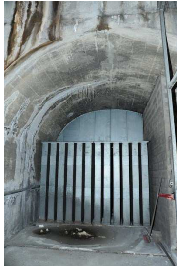
Figure 4 : Vue de l'étage de silencieux côté puits
