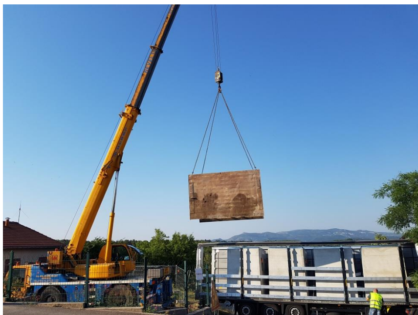
Pose des contenants : Belcodène, Avenue de la Ste Victoire
